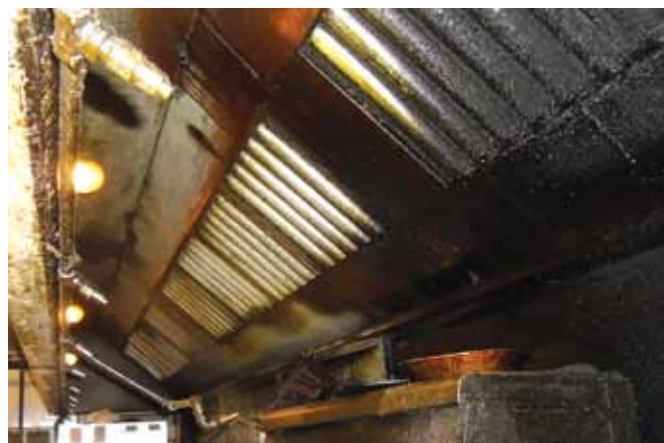
אירוע אש ידוע מראש בשל מינדף מוזנח. תעלת אוויר אופיינית למטבח עם טיגון עמוק עם שקעים שומניים קשים להסרה ודליקים בטמפרטורה של 200^{\circ}\text{C} בלבד.
