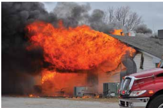
שריפה שנגרמה מדליקת מסעדה במנצ'סטר, אנגליה. נוכחות שמנים בתעלות נידוף והספקת אוויר ע"י המאוורר גרמו להתלקחות מהירה והרס מוחלט של הבניין
