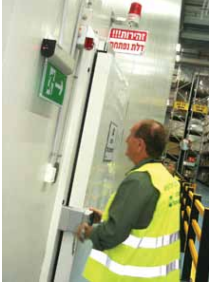
מערכת אזהרה למניעת מפגש בין המשתמש במעבר להולכי רגל לבין מי שיוצאים מהמקור
