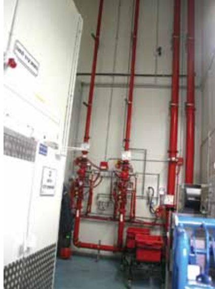
מערכת כיבוי אש עם מערכת אבטחה כפולה למניעת נזקים בעת תקלה
